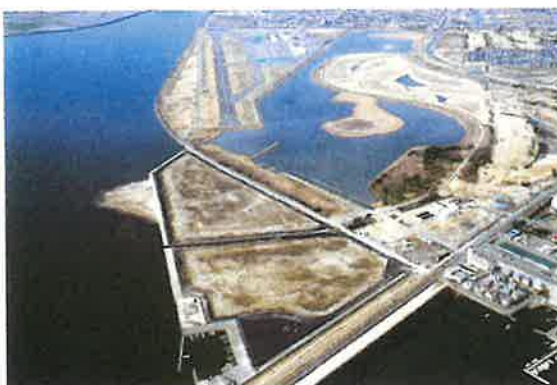
人工干潟周辺の埋立作業状況 (平成18年)
