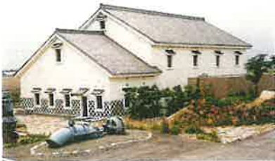
七区排水機場
