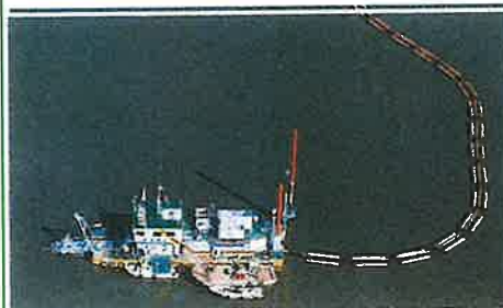
浚渫船で底泥を吸い込み
