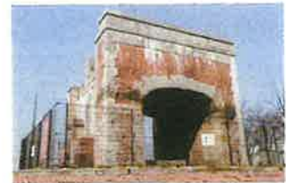
桜の馬場樋門
