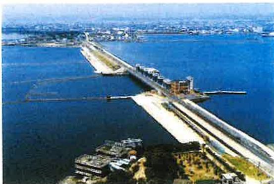
排水樋門施工中
