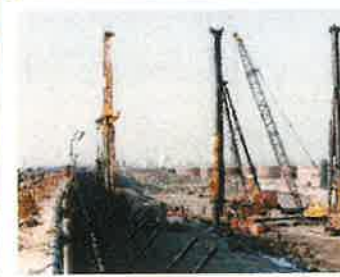
新樋門建設工事の様子
