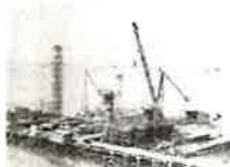
コンクリート工
