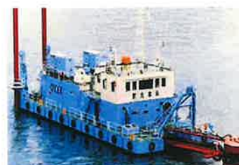
児島湖に浮かぶ底泥浚渫船
